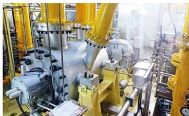
改造前的调压站A增压机采用进口品牌增压机和控制系统，运行过程中存在控制稳定性不足、防喘阀开度过大等问题；同时原调压站整个系统因存在多个独立部分、程序功能不完善等原因未能完全实现自动控制。这些都给华电武昌热电的业务效率及效益提升带来不小阻力：
